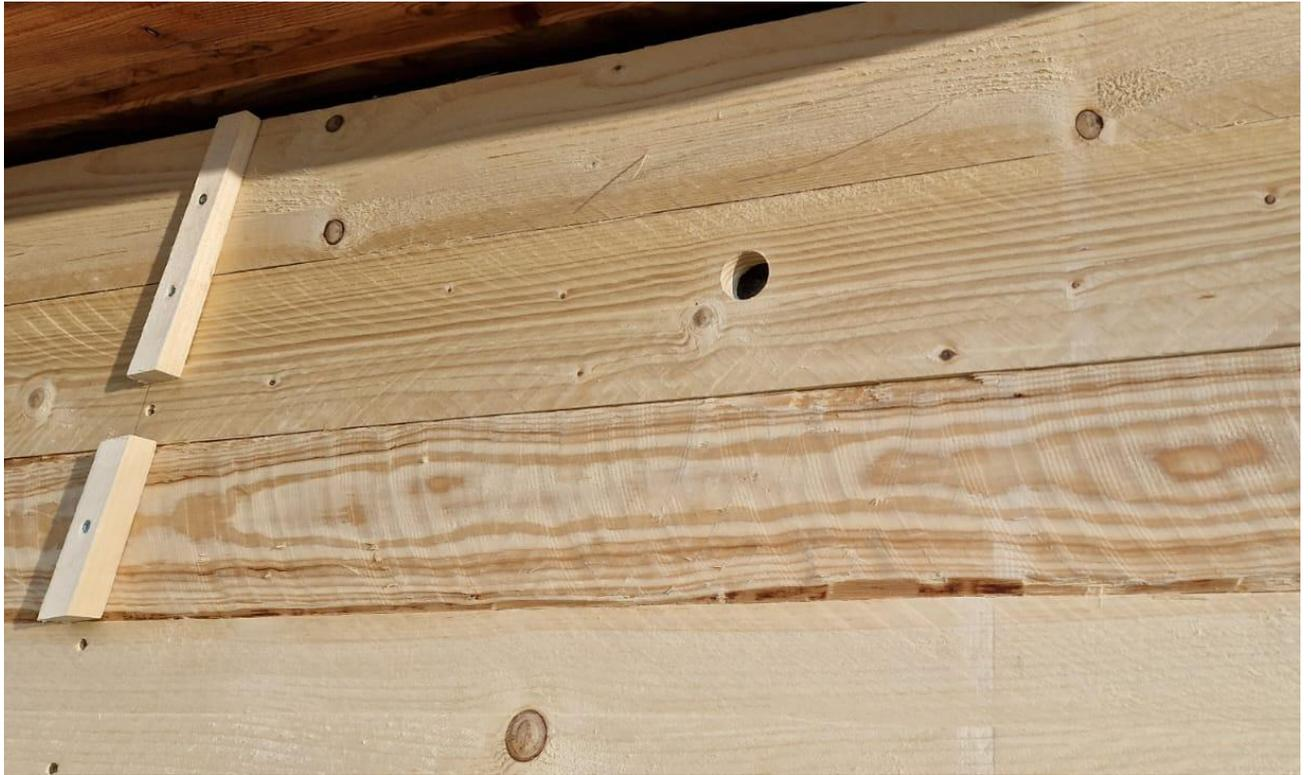
**Abbildung 8** Spaltenquartiere beim Bau mit Verbindungen zu neben- und hinterliegenden Kammern.
