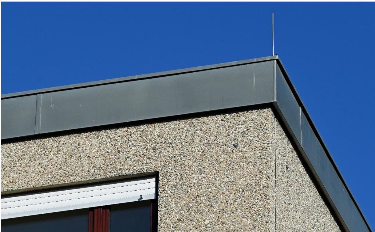
**Abbildung 18** Beispiel für einen Quartierbereich hinter einer neuen Dachrandverwahrung (Foto: C. Dietz).
