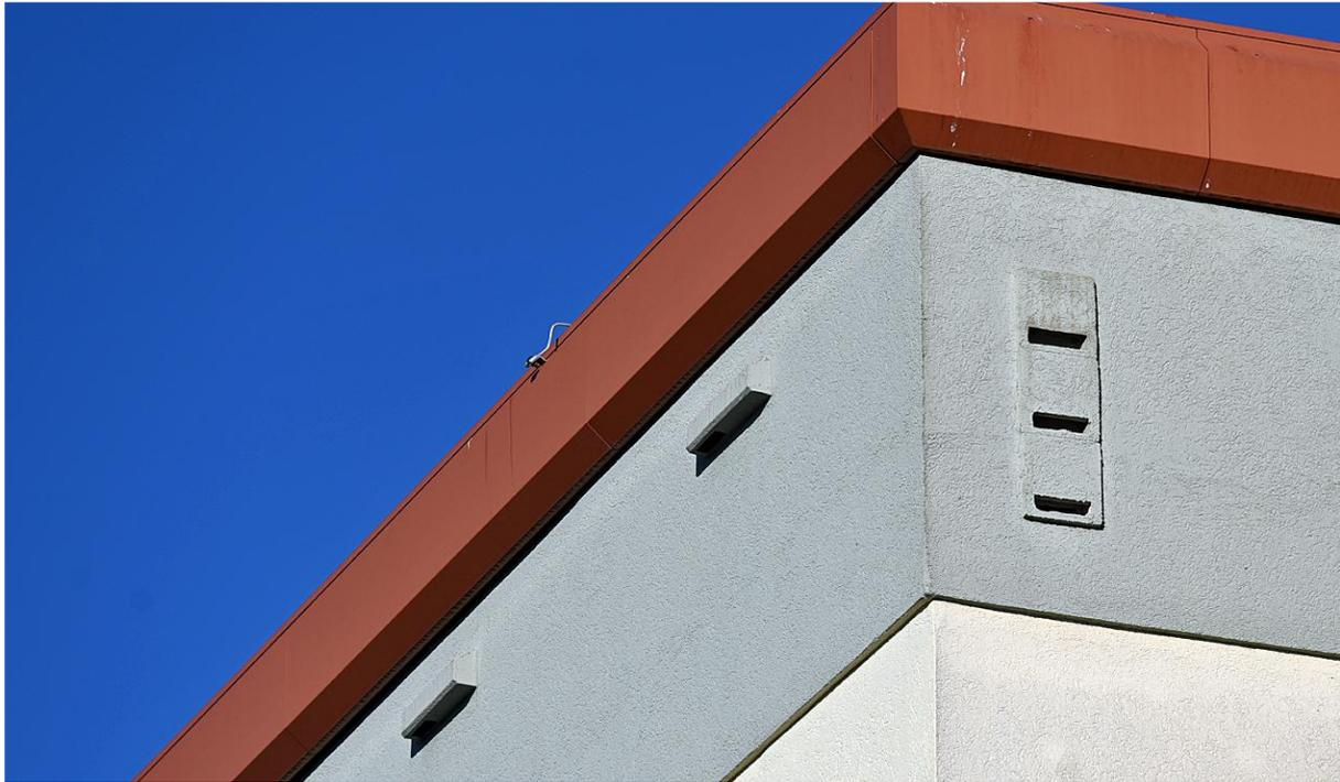
**Abbildung 19** Beispiel für verschiedene (teil)integrierte Quartierbereiche (Foto: C. Dietz).
